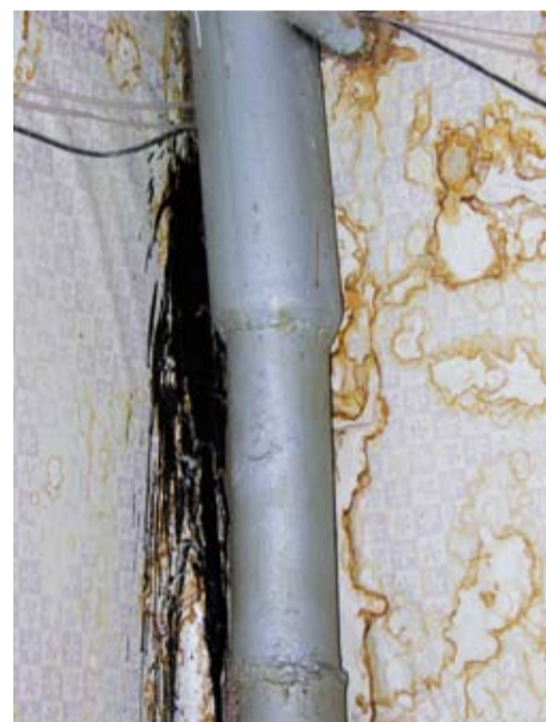
Специалисты УК «Прогресс» заделали щели так, что гудрон потек прямо по стояку (рядом с квартирой № 143).
